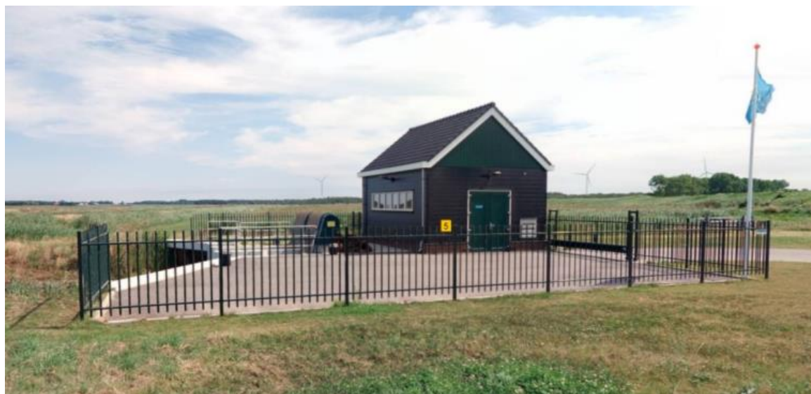
afb.1 Referentie: gemaal Waard Nieuwland (bron: HHNK)
