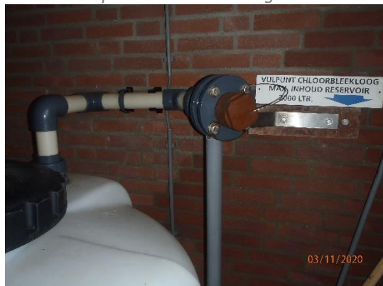
Foto 13: Vulpunt Chloorbleekloog
