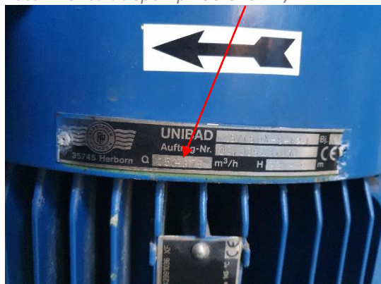
Foto 7: Circulatiepomp 150-375 \text{m}^3/\text{h}
