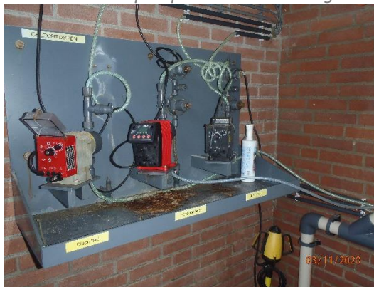
Foto 14: Doseerpompen chloorbleekloog
