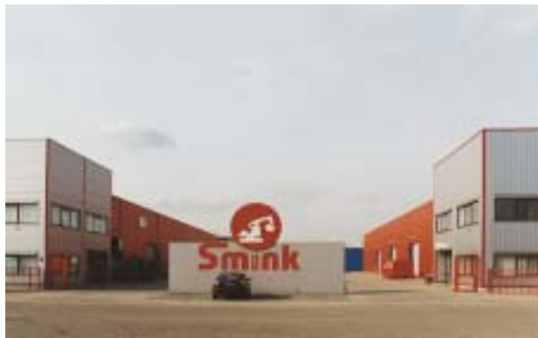
Buitenopslag op verantwoorde manier afschermen.
