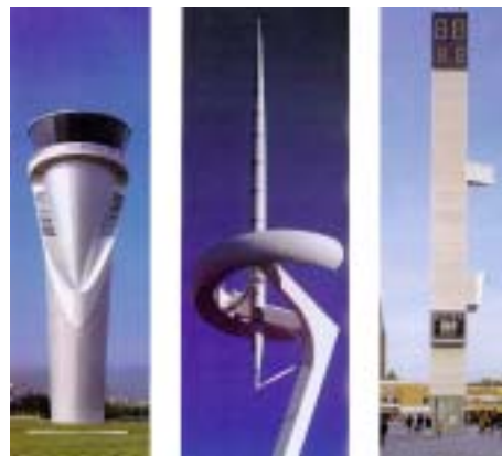
Landmark als losstaand object, hoger dan omringende bebouwing.
