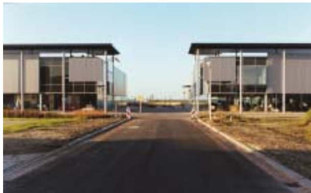
Inrit naar binnenterrein bedrijfsverzamelgebouw.
