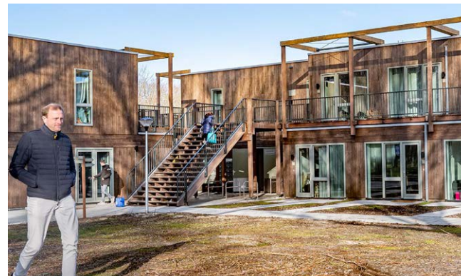
Overgang herkenbaar door balkonnen, trappen en op maaiveld door een tegel terras
