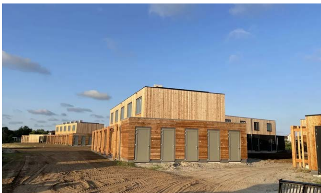
Voordeuren en bergingen ontsloten aan straatkant, terras aan de (collectieve) groene ruimtes
