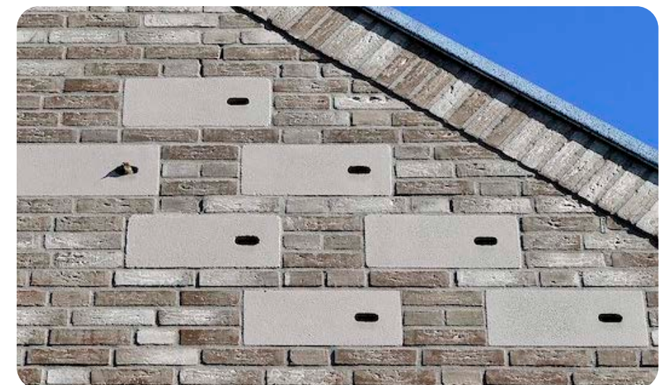
Toepassing ingebouwde nestkasten in kopgevels
