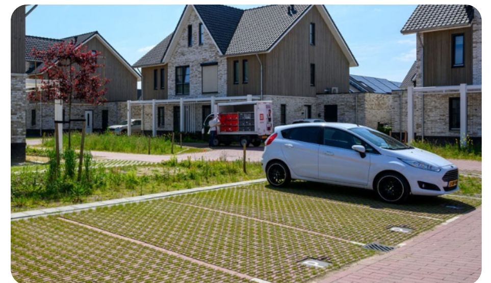
Parkeergelegenheid in halfverharding
