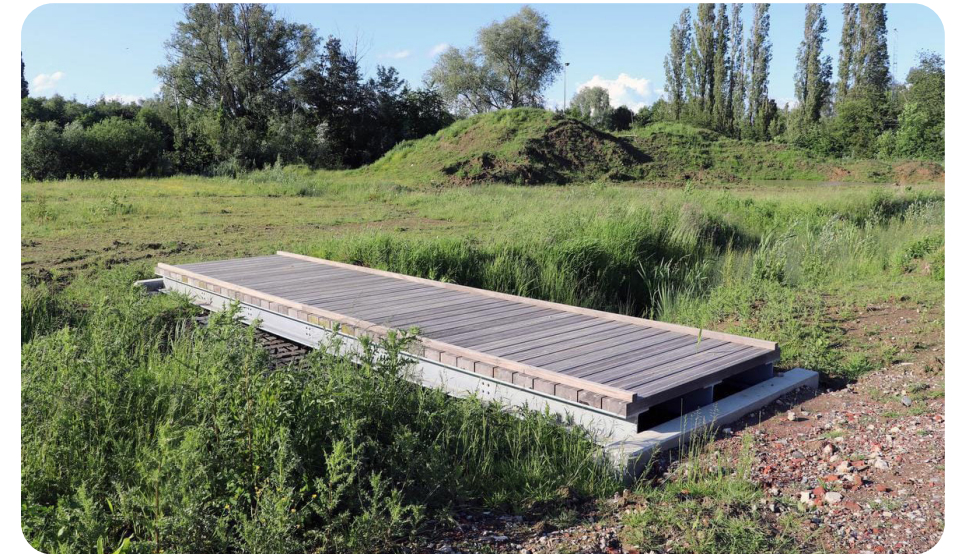
Beeld van een wandelroute door waterretentiegebied
