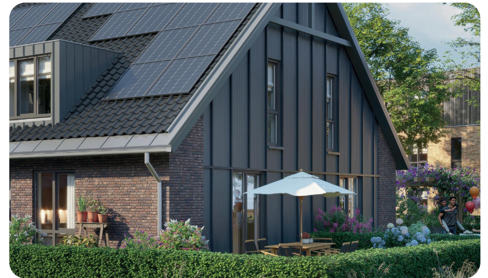
Verbijzondering kopgevel met afwijkende materialisering
