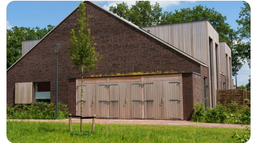
Kopgevel met meeontworpen bergingen in combinatie met gevelopening
