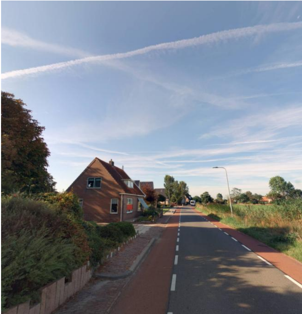
Voorbeeld toepassing opsluitbanden (met natuurlijke afwatering)
